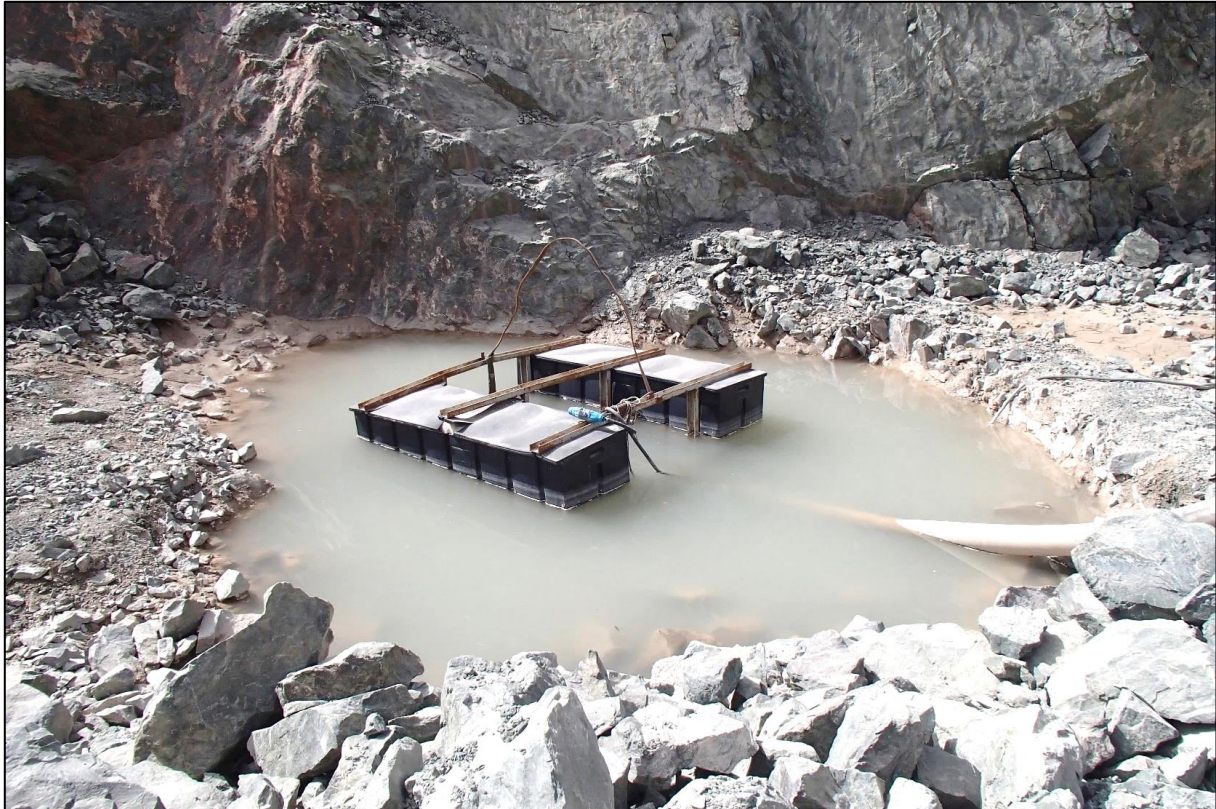
Figure 22 - Bassin de pompage en fond d'excavation
