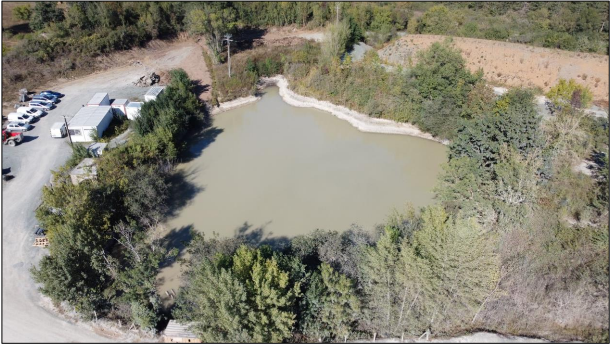
Figure 23 - Le bassin de décantation recevant les eaux d'exhaure de la carrière
