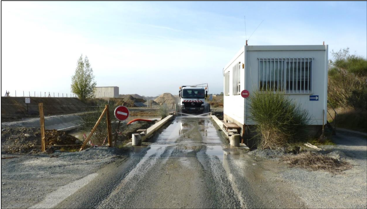
Figure 48 - Sortie avec dispositif lave-roues et rampe d'arrosage
