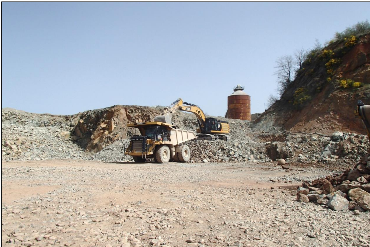
Figure 17 - Opération de reprise du matériau en pied de front
