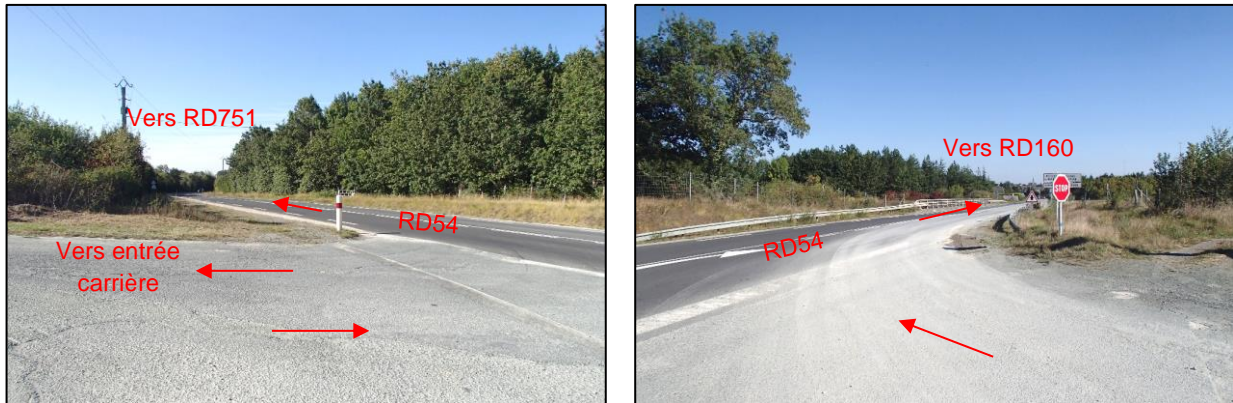
Figure 61 - Débouché sur la RD54 depuis la voie d'accès à la carrière
