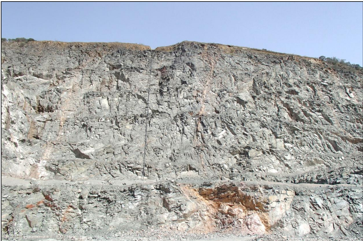
Figure 8 - Vue sur les fronts actuels (Avril 2021)
