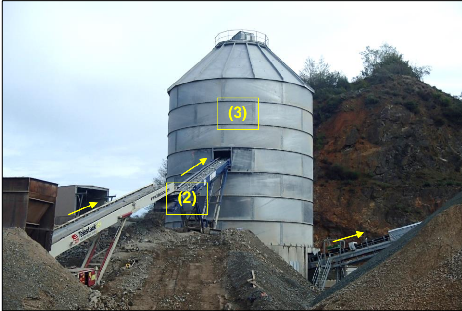
Figure 31 - Convoyage des matériaux primaires concassés vers le silo
