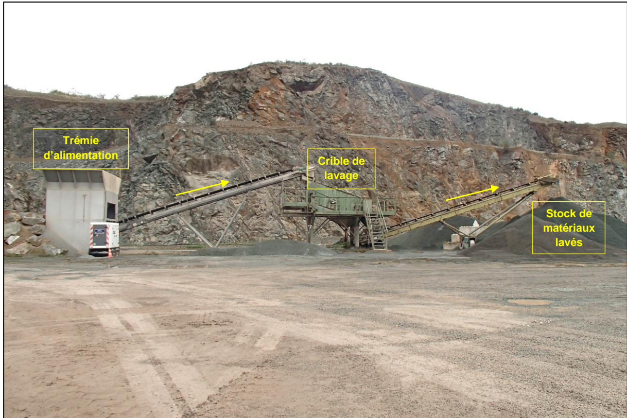
Figure 37 - L'installation de lavage des matériaux
