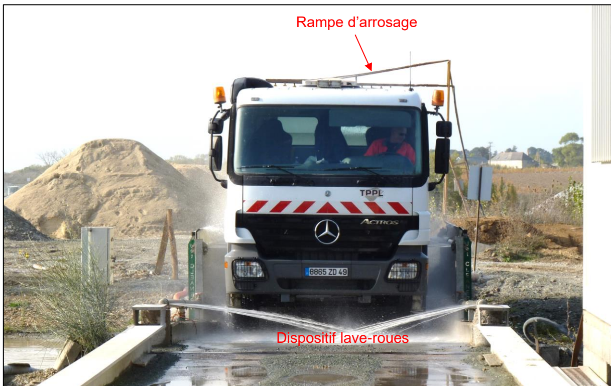
Figure 7 - Camion dans dispositif lave-roues et rampe d'arrosage en place
