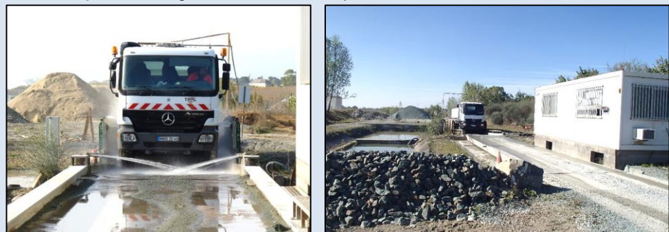
Figure 74 - Dispositif lave-roues et rampe d'arrosage des camions
