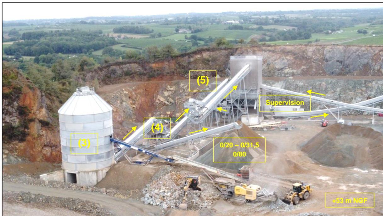
Figure 32 - Vue sur la partie primaire de l'installation de traitement
