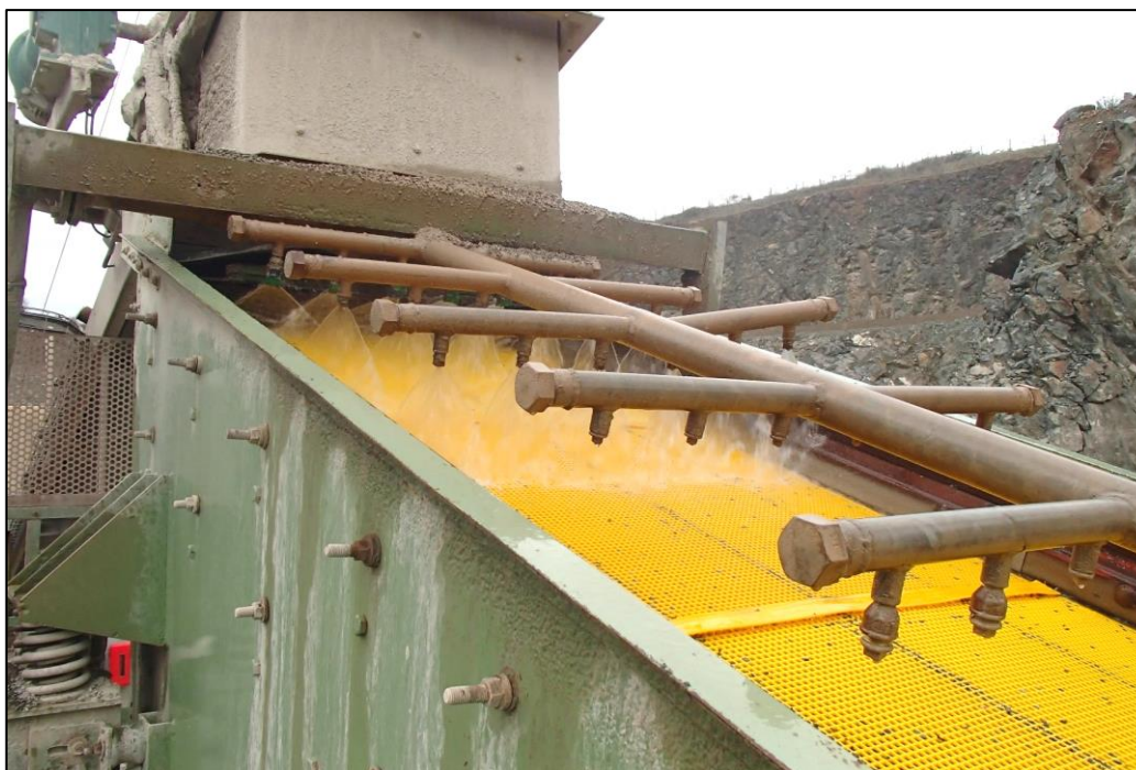
Figure 39 - Crible de lavage actuel
